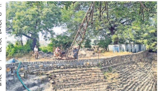
పూడికతీత పనుల్లో భాగంగా సఫాయిబావి వద్ద ఏర్పాటు చేసిన క్రేన్
