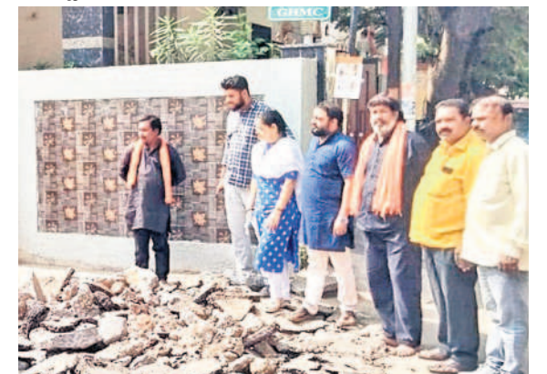
మాధవరావు ఠేన్లో చేపట్టిన రోడ్డు నిర్మాణ పనులను పరిశీలిస్తున్న కార్పొరేటర్ పావని
