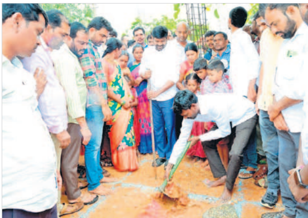
అదనపు తరగతి గదుల నిర్మాణ పనులను ప్రారంభిస్తున్న విప్ గువ్వల బాలరాజు
