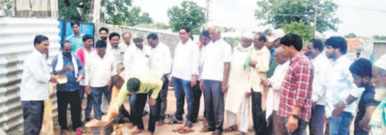
సీసీ రోడ్డు నిర్మాణానికి భూమిపూజ చేస్తున్న జడ్పీ వైస్ చైర్మన్ కోనేరు కృష్ణారావు
