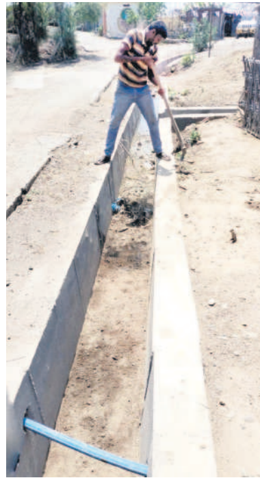
ఎస్సీ కాలనీలో నిర్మించిన డ్రైనేజీ
