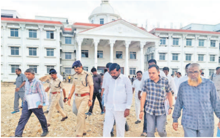
జిల్లా పోలీసు కార్యాలయ నిర్మాణ పనులను పరిశీలిస్తున్న మంత్రి జగదీశ్ రెడ్డి
