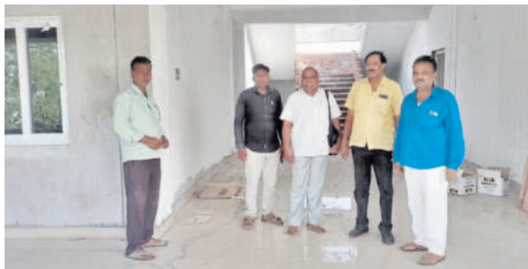
భవన నిర్మాణ పనులను పరిశీలిస్తున్న జడ్పీటీసీ సభ్యుడు నారోజి గంగారాం
