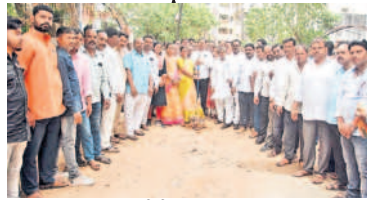
కాశీరాంజీరాల్లో సీసీరోడ్డు పనులను ప్రారంభిస్తున్న ఎమ్మెల్యే కాలేరు వెంకటేశ్, కార్పొరేటర్,
